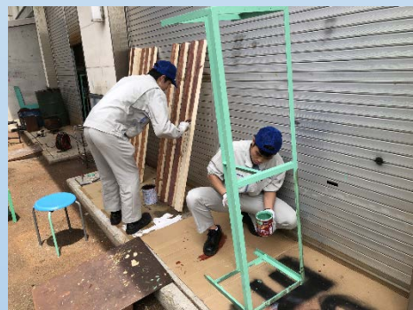
ベンチ補修の様子
